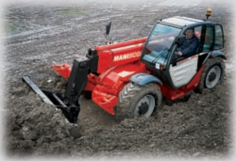
ERDARBEITEN : Heben/Absenken + Graben und ausschütten
